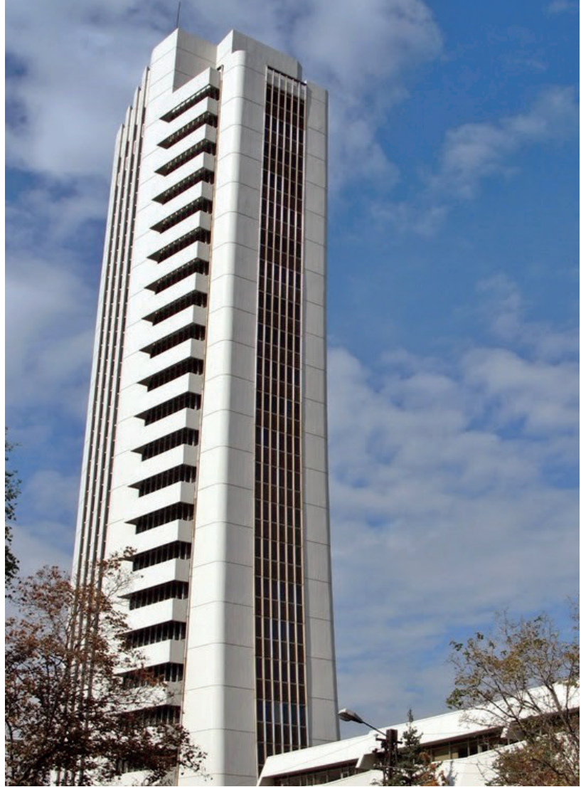
RESİM 1 - Bakanlık Ek Binası
