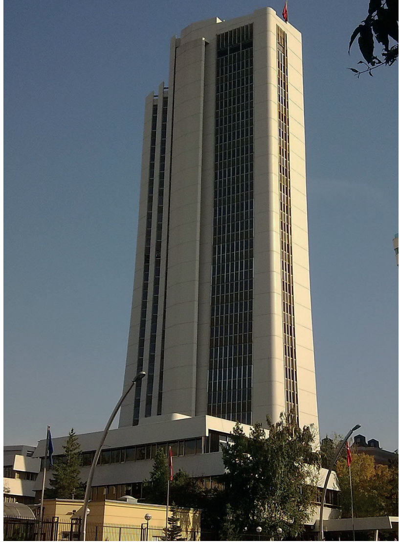
RESİM 1 - Bakanlık Ek Binası
